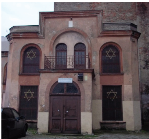
Fot.1. Elewacja synagogi – Łódź, Rewolucji 1905
